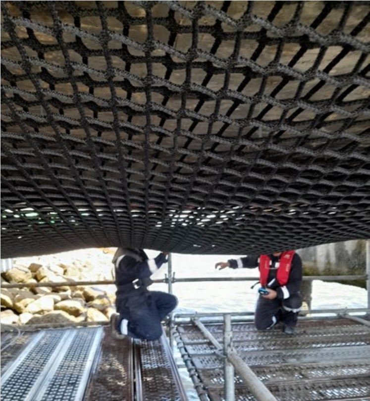
Aplicação de rede polipropileno
