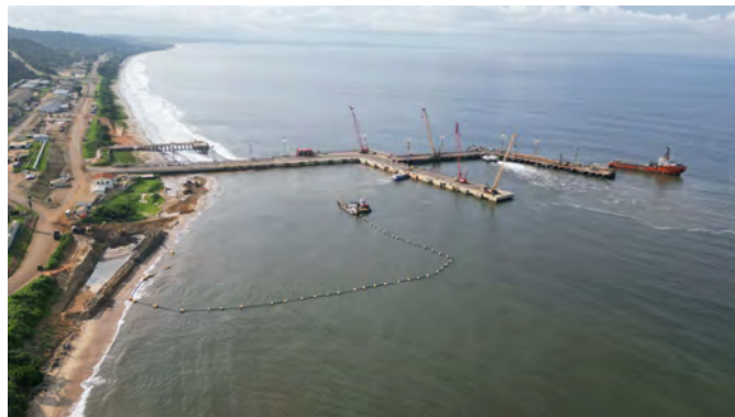
Zona das dragagens durante os trabalhos sendo visível a draga de sucção. Zone of dredging during the works, being visible the suction dredger CSD 450.
