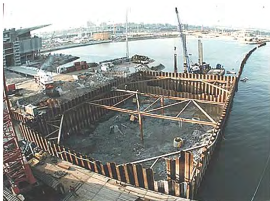
Ensecadeira da eclusa Lock cofferdam
