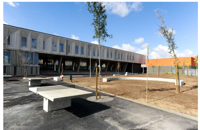
Vista geral dos edifícios da escola
