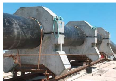
Lançamento da tubagem e vista durante a construção. Pipe launching and Construction in progress.
