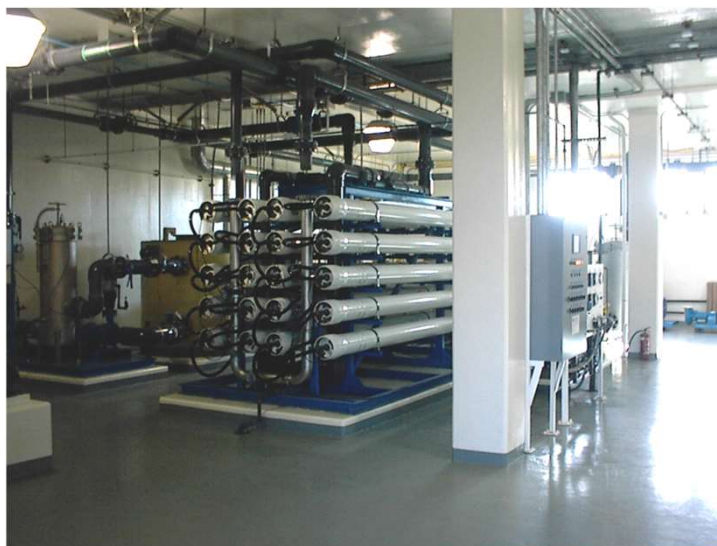
Baterias de membranas Membrane stacks
